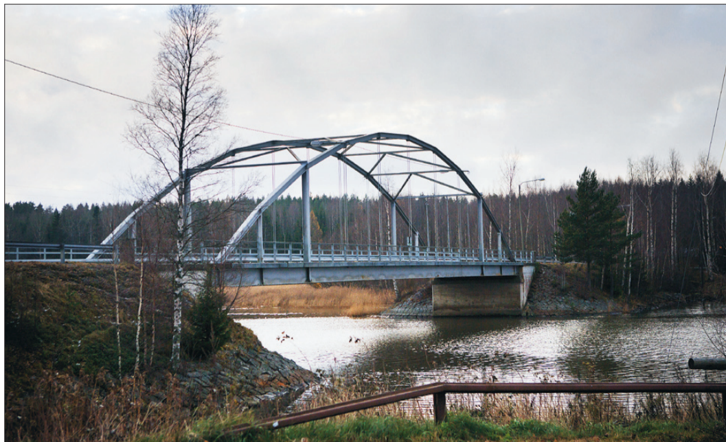
Hellnäs bro ska repareras och är stängd för trafik i fem veckors tid.
